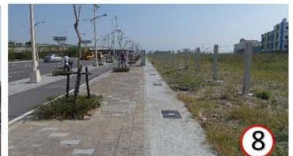
環中路南側局部仍為14期施工圍籬，台74橋下木本灌木生長尚佳，但喬木狀況不良，多株已枯死
