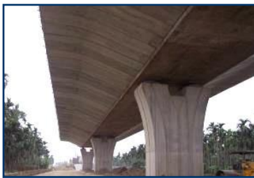
預鑄斜撐板預力箱型梁橋
