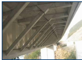
預鑄斜撐柱鋼腹鍍合成梁橋
