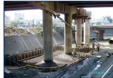
自充填混凝土施工免掛實
