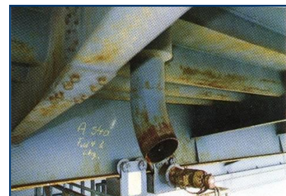
鋼結構腐蝕
